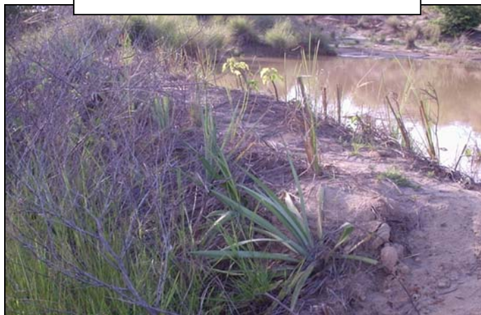
Mise en place d'un bassin de décantation
